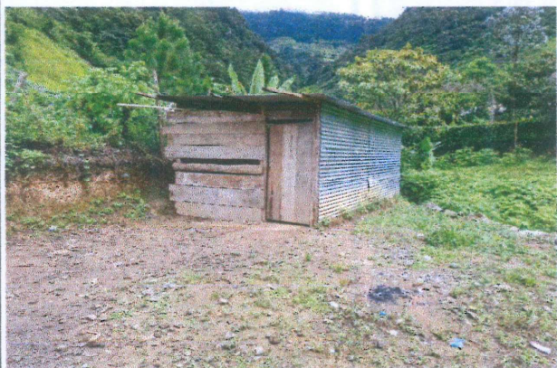
Foto1: Mejoramiento de estructura tipo pórtico
