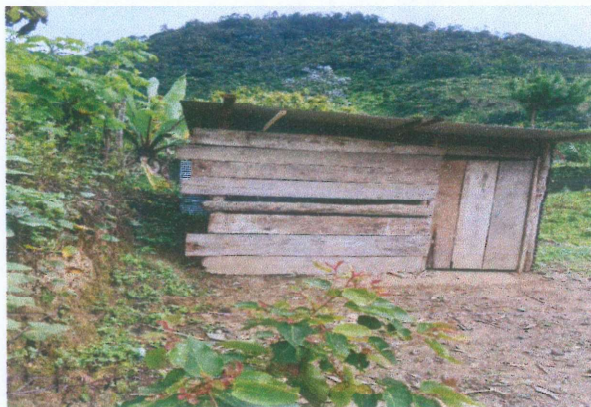
Foto 2: Instalación de lámina troquelada calibre 26
